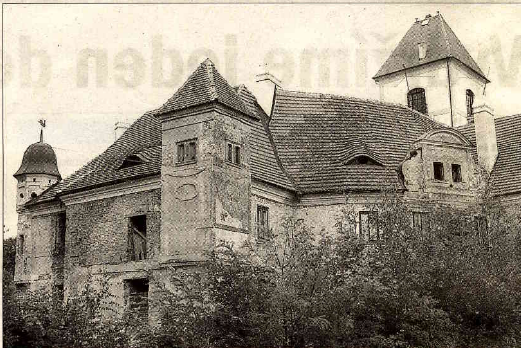
Oprava zámeckého komplexu (na snímku jeho zadní část) v Poběžovicích postupuje pomalu. Vedle již opravených prostor byla letos nově zpřístupněna také vyhlídková věž. Archiv MěÚ Poběžovice
