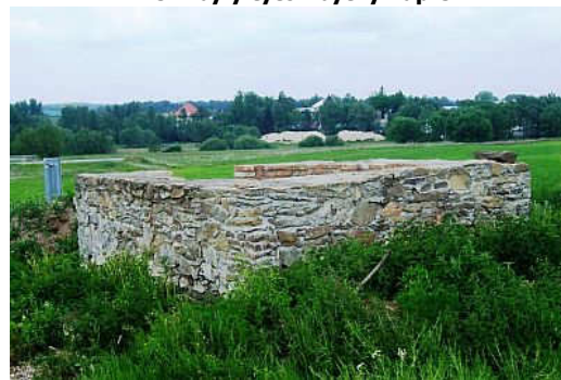
V květnu 2012 bylo opravené základní zdivo.
