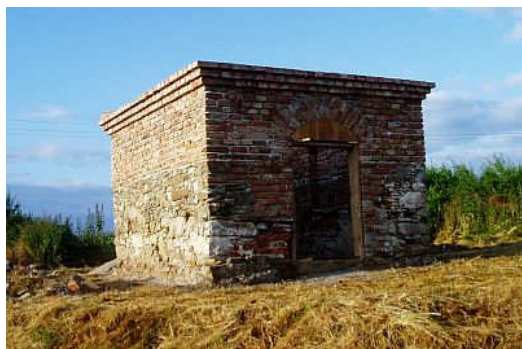
Na jaře 2014 byly vyzděny cihlové zdi.
