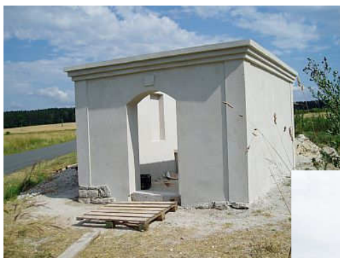
Dále byla stavba opatřena omítkou.
