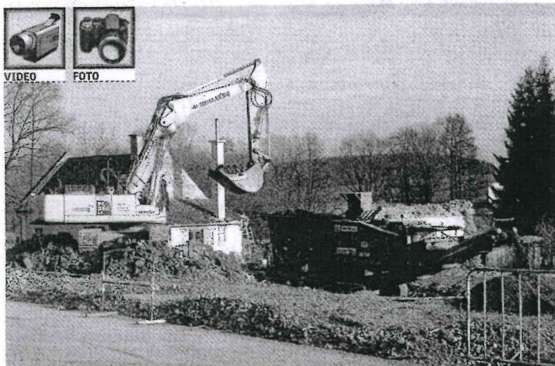
STAVEBNÍ SUŤ ze zdemolované budovy bagr přemísťuje do speciálního stroje, který z ní tvoří jemnější drť. Foto: Deník/Josef Babor Fotogalerie a video na www.domazlicky.denik.cz
