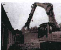
ŘÍJEN 2011. Demolice staré školky
